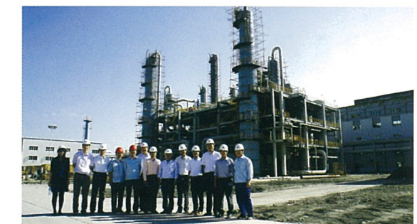
世界初の石炭由来のエチレングリコール製造プラント
