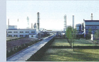
内モンゴルに移設したメタノールプラント
