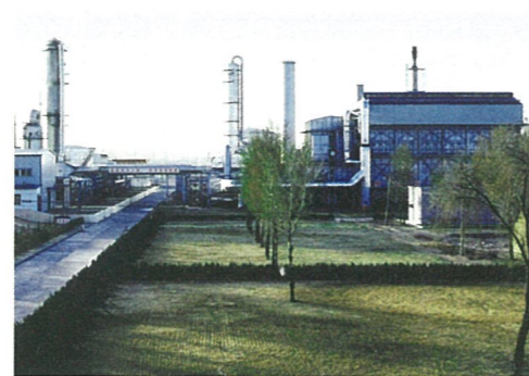
内モンゴルに移設したメタノールプラント
